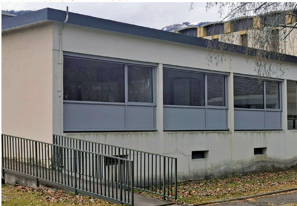
Photo 2. (Crédit C. Bernard, LPSC). - Nouveaux châssis vitrés au bâtiment 9.
