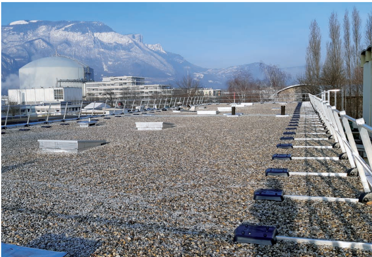
Photo 1. (Crédit C. Bernard, LPSC). - Rénovation et isolation du toit du bâtiment 7.
