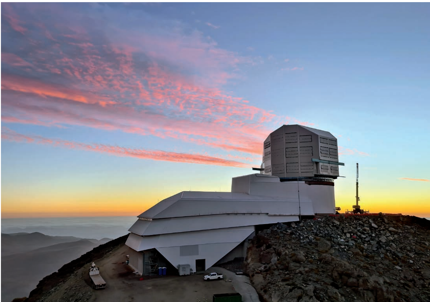
Figure 1. (crédit : Rubin Obs/NSF/AURA). - Photo (avril 2022) de l'observatoire Vera. C. Rubin, en construction au Cerro Pachón, au Chili, à 2682 m d'altitude.
